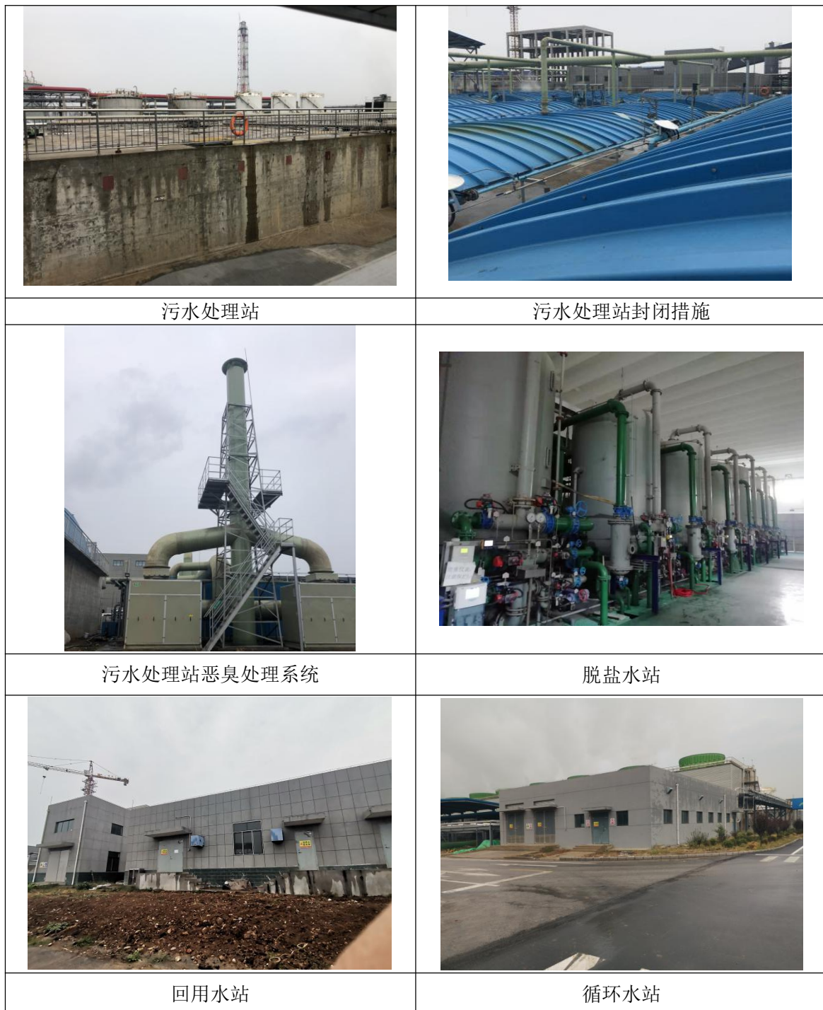
图4.1-2 项目废水治理设施
