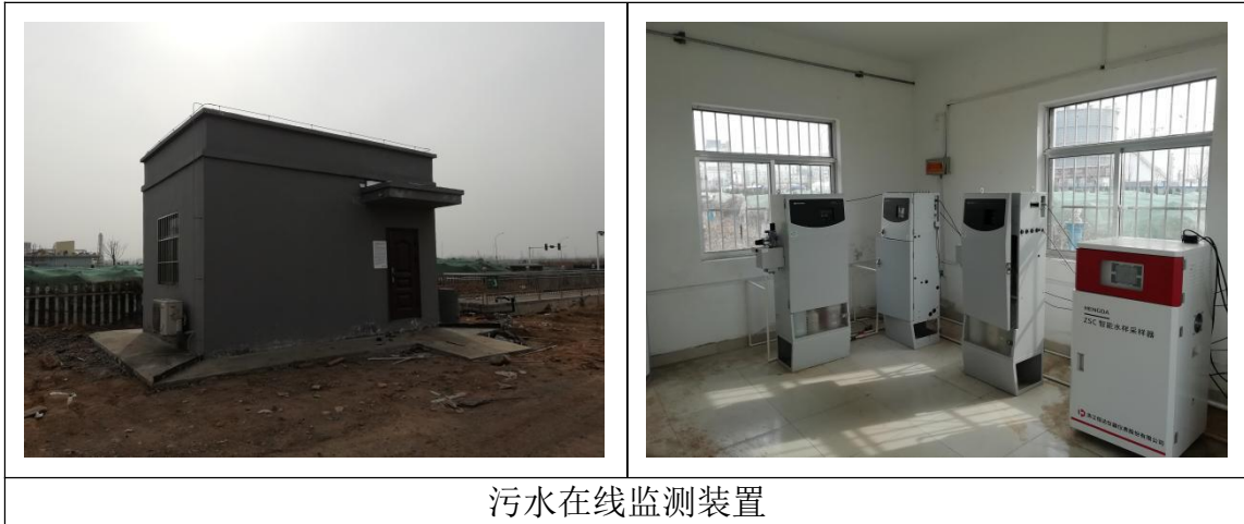
图 4.2-10 污染物排放口在线系统安装情况
