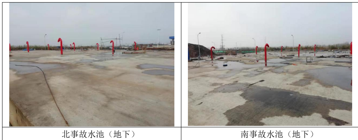
图4.2-3 二级防控措施建设情况
