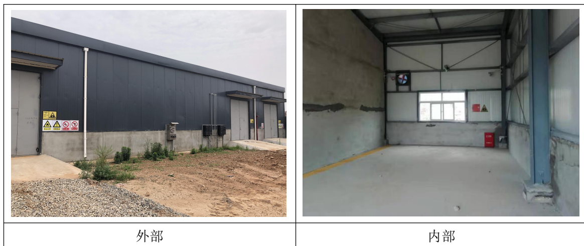
图4.1-4 危废暂存库建设情况
