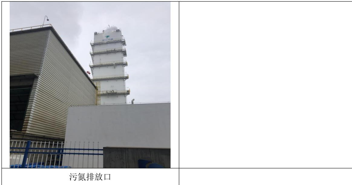
图4.1-1 项目有组织废气治理设施
